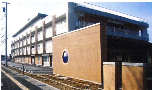
完成間近向陽苑木曳野
