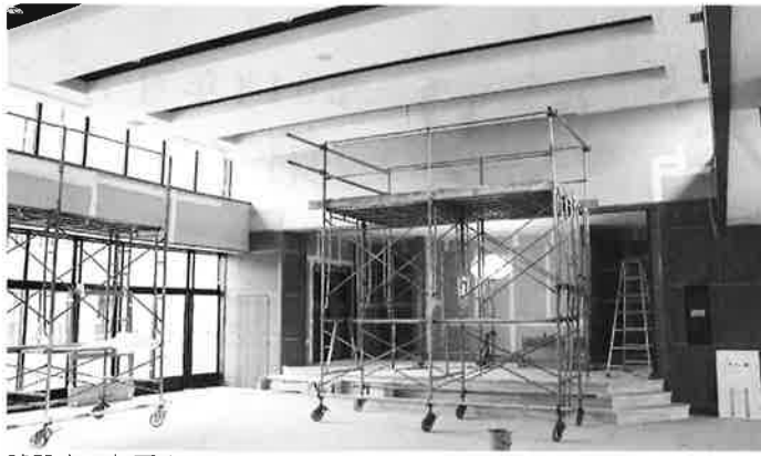
建設中の仁愛ホール
