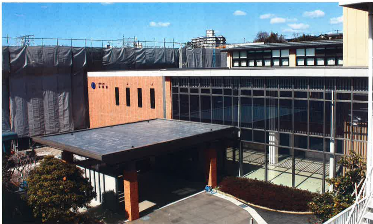
四月からリニューアルする管理棟
